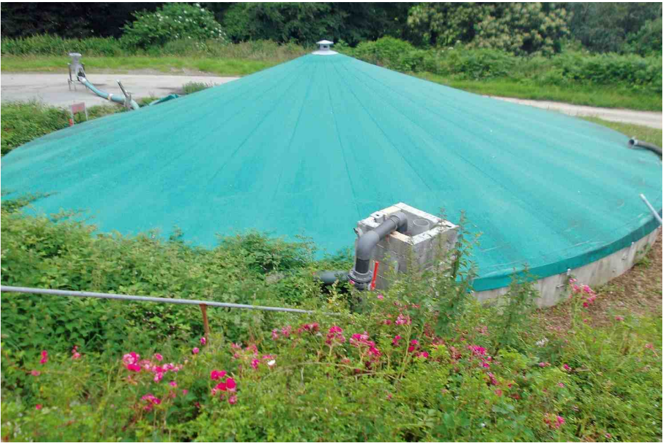
Avec une couverture de fosse, les émissions d'odeurs peuvent être totalement supprimées. ©A.-S. Langlois
